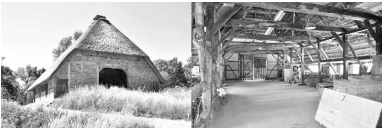
Abb. 1: Niederdeutsches Hallenhaus in Fachwerkbauweise, die Instandsetzung erforderte die Festigkeitssortierung des verbauten Holzes – links: Außenansicht; rechts: Innenansicht der tragenden Holzkonstruktion
